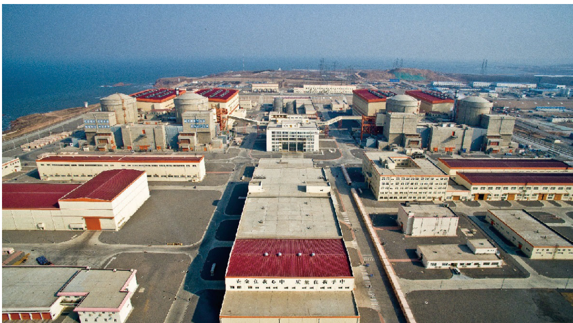
紅沿河核電一期工程全景
