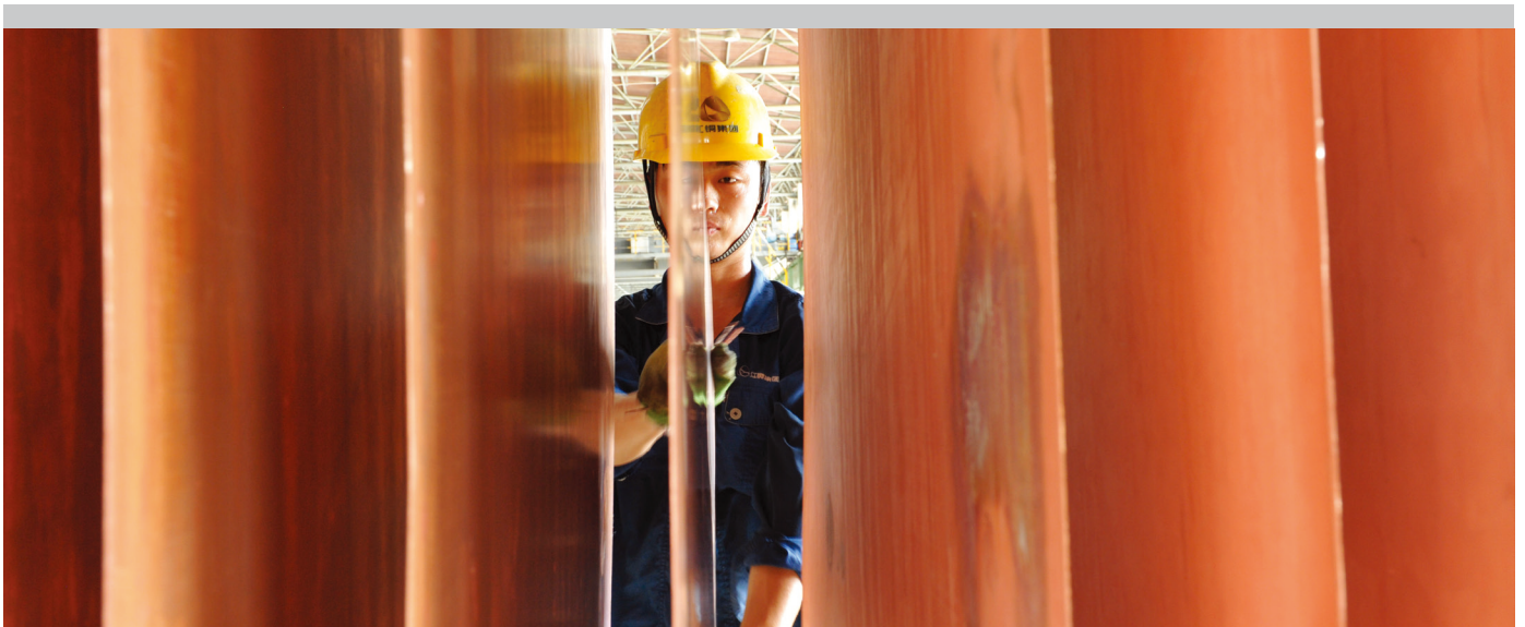
江西銅業操作工人電解作業現場
