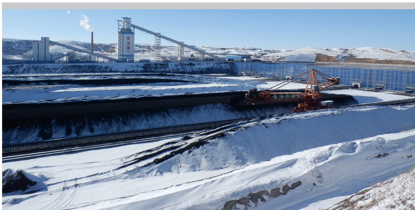
內蒙古伊泰化工有限責任公司建設的120萬噸年精細化學品已按計劃於近日打通工藝流程，進入聯合試運轉階段
