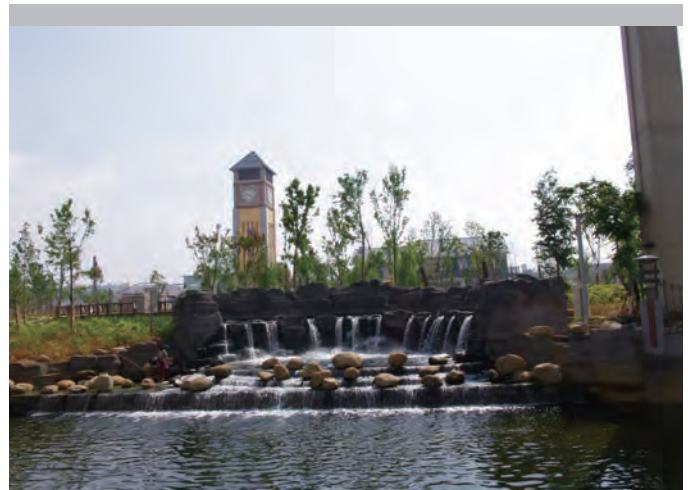
採用3AMBR工藝的昆明第十污水處理廠出水口，出水水質優於一級A標準
