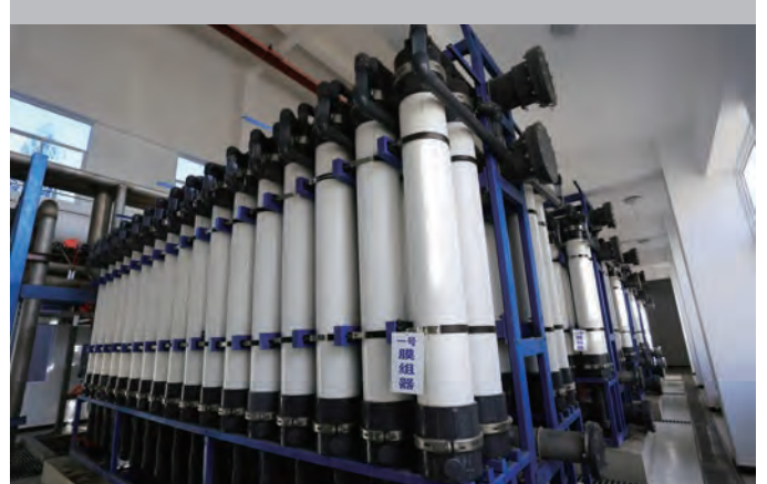
雲南水務水廠膜設備間，採用CMF膜工藝，出水可優於國家飲用水標準
