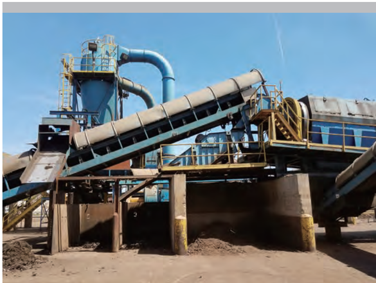
齊合環保先進設備
