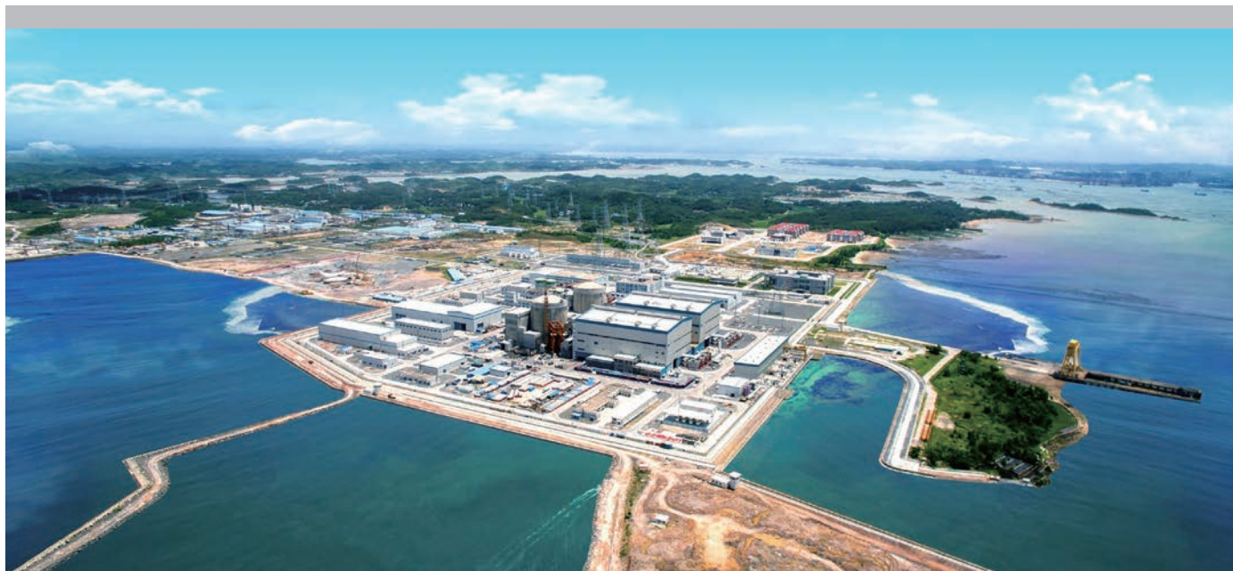
中廣核電力防城港核電站
