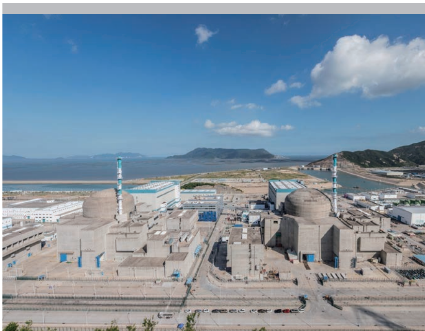
中廣核台山核電基地。
