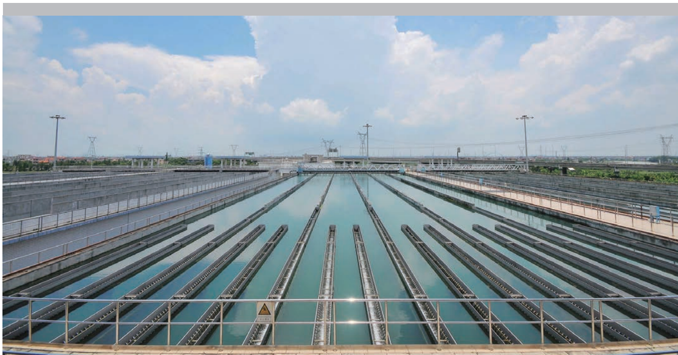
雲南水務中標清遠清新區生活污水處理PPP項目。
