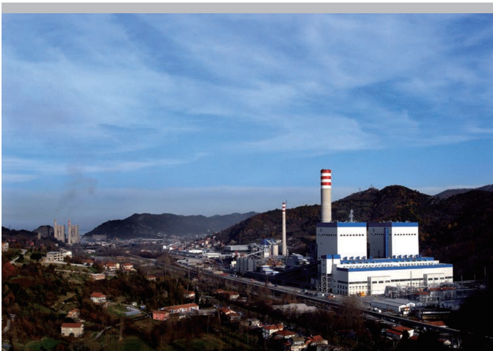
中國機械設備工程，公司以工程承包為核心業務，以貿易、投資、研發以及國際服務為主體的工貿結合、技貿結合的大型國際化綜合性企業集團。
