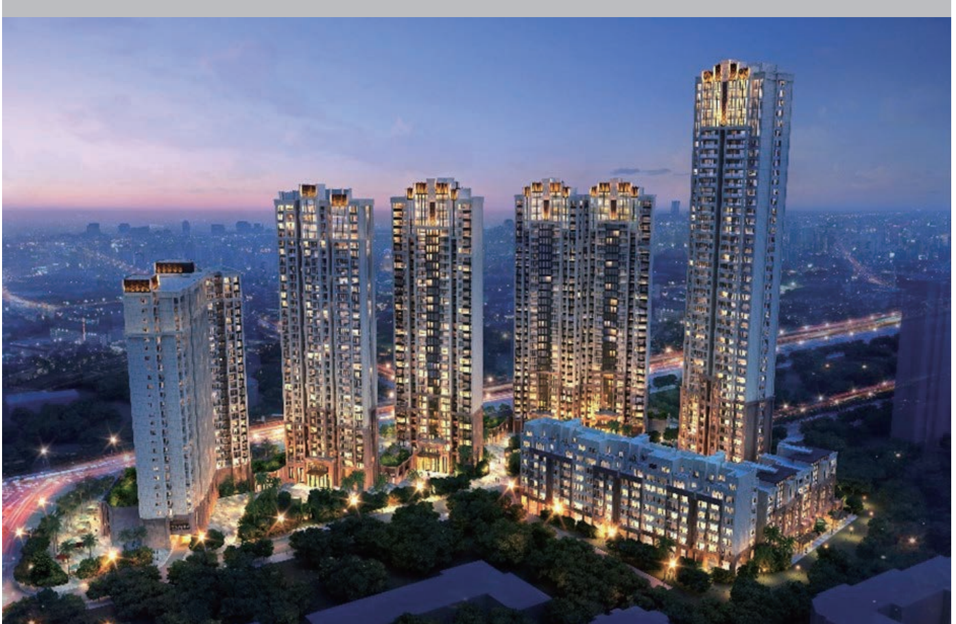
(住宅類物業管理項目：廣州華發四季圖片)
